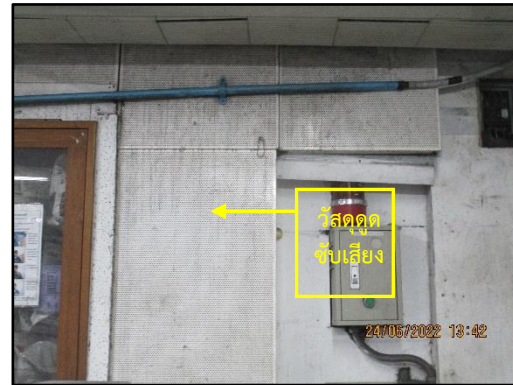
ภาพที่ 2.22 (ต่อ) ห้องควบคุมที่ติดตั้งระบบปรับอากาศและวัสดุดูดซับเสียงในสายการผลิต
