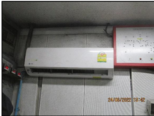
ภาพที่ 2.22 (ต่อ) ห้องควบคุมที่ติดตั้งระบบปรับอากาศและวัสดุดูดซับเสียงในสายการผลิต
