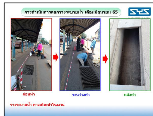
ภาพที่ 2.13 การขุดลอกทรายระบายน้ำภายในโครงการ
