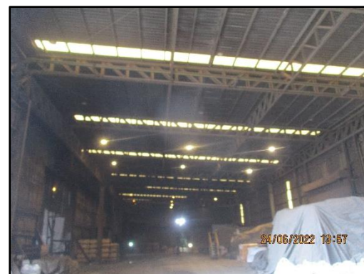
ภาพที่ 2.31 หลังคาครอบถนน บริเวณที่รถขนส่งตะกรัน (Slag) วิ่งออกจากตัวอาคาร
