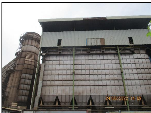
ภาพที่ 2.1 ระบบดักฝุ่นแบบถุงกรอง (Bag Filter) ภายในหน่วยถุงกรอง (Bag House)
